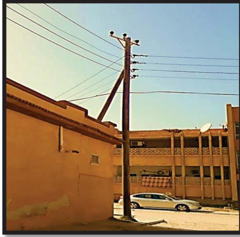
المصدر: عدسة الباحثة، بتاريخ 2021/5/19 الصورة (13): المنظر البصري المشوه لأسلاك الكهرباء
