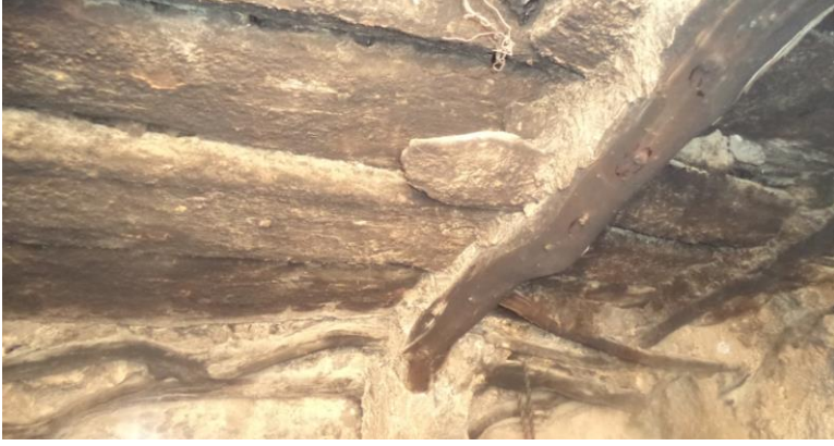
صورة سقف بجذوع أشجار النخيل وحوامل من أعمدة الزيتون
