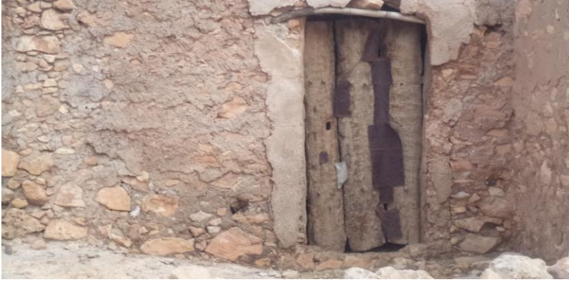
صورة تبين باب حجرة مصنوع من شجر النخيل
