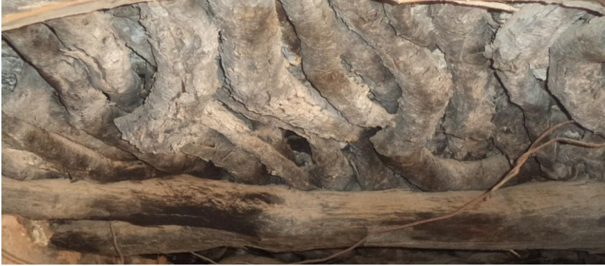
صورة تبين سقف بجذوع أشجار الزيتون
